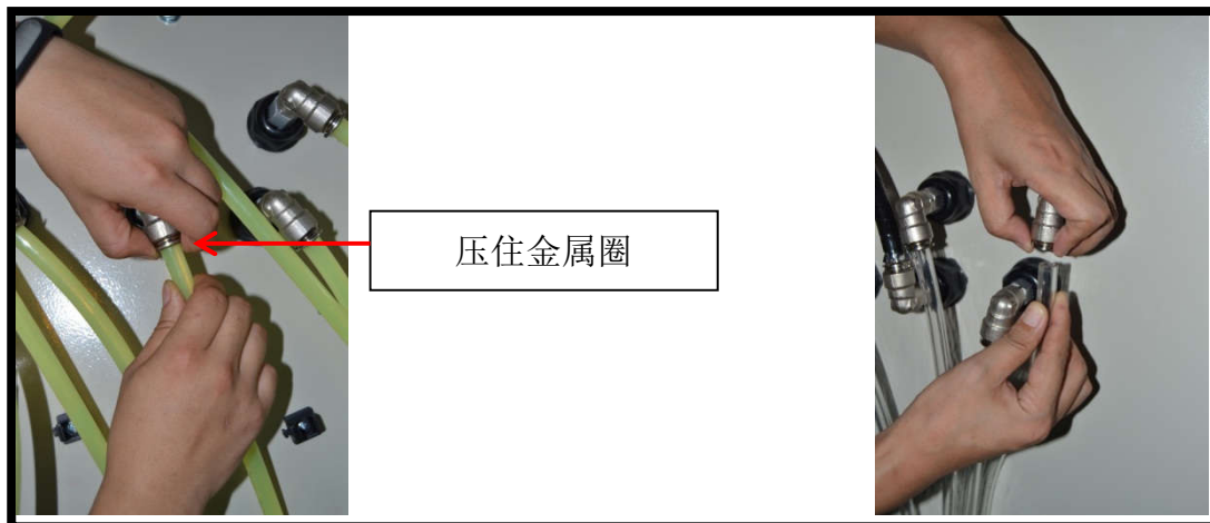
图 36: 水管拆卸方法
