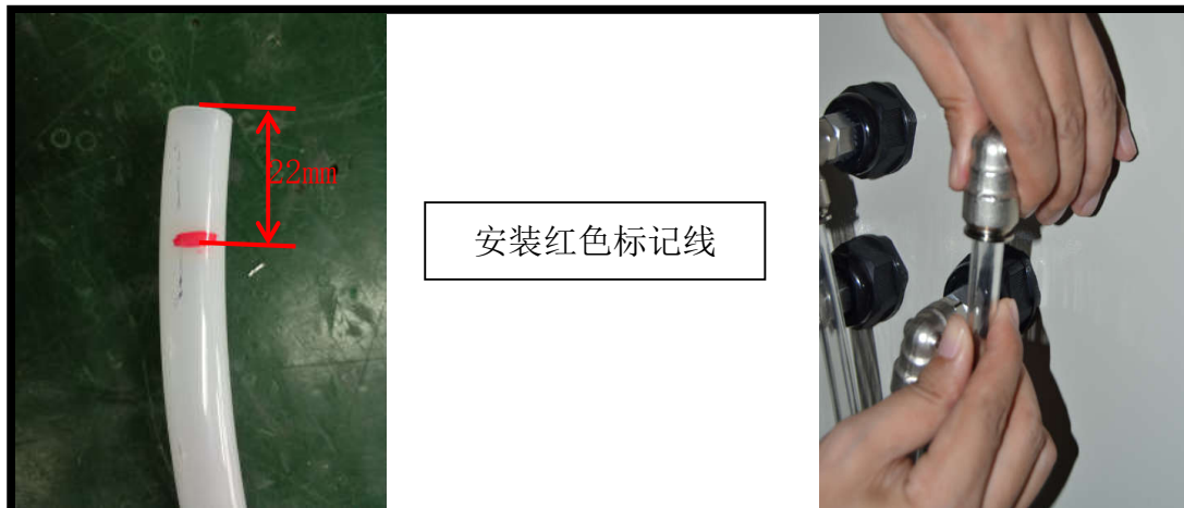
图 37: 水管安装方法
